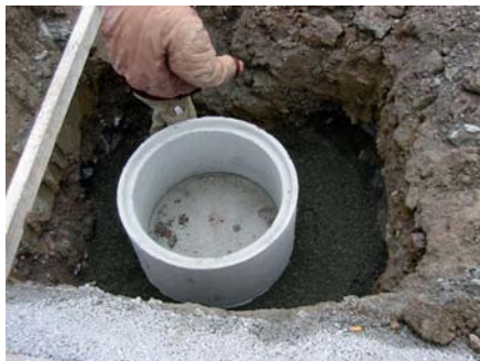
Установка бетонного кольца (по требованию заказчика)
