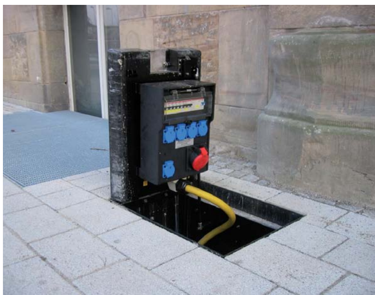
Установка CAMPETTO завершена
