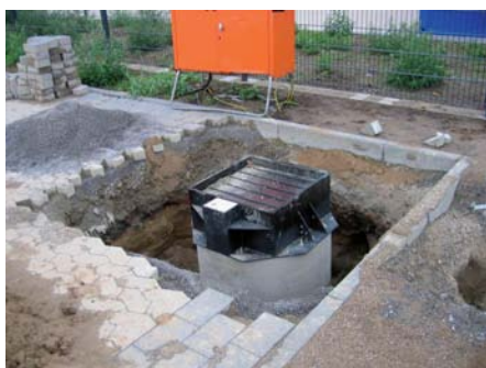
Помещение всего устройства в подготовленную яму
